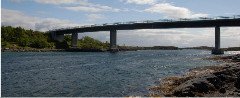
Diese Brücke verbindet Vega mit der vorgelagerten Insel Igerøya.
